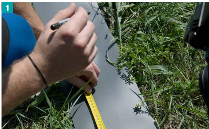
1 Stínící plotovou výplň si rozvineme a ustříháme na šířku pletiva.
